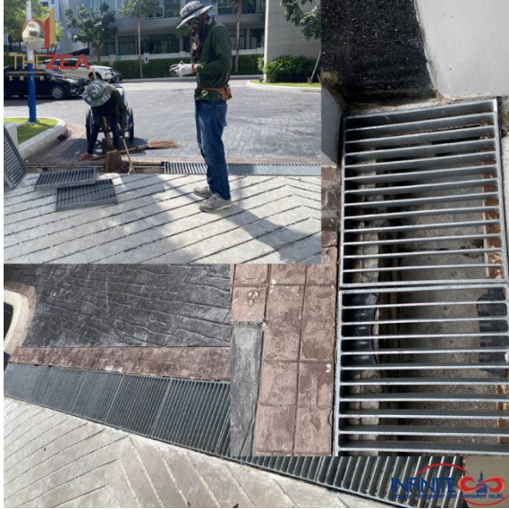
ภาคผนวกที่ 3.17 ตรวจสอบการอุดตันของท่อระบายน้ำในโครงการ
