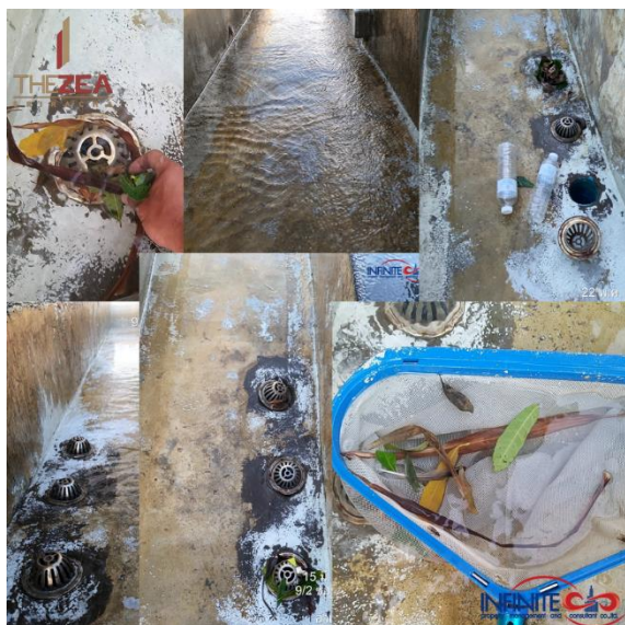
ภาคผนวกที่ 3.42 ตรวจสอบรางระบายน้ำล้น และฝาปิดรอบสระว่ายน้ำ
