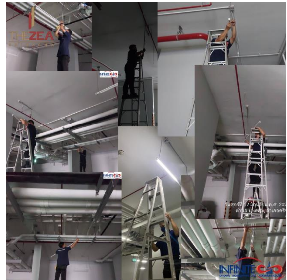
ภาคผนวกที่ 3.31 ช่างอาคารทำการเปลี่ยนหลอดไฟส่องสว่างลานจอดรถที่ชำรุด
